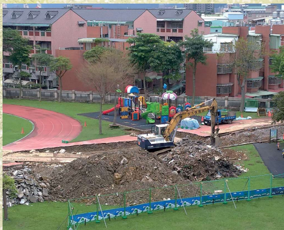
進行操場下陷補強工程
