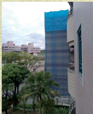
進行校舍防漏水工程
